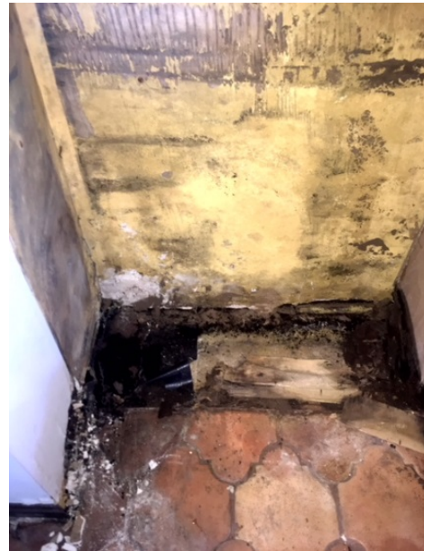
Expose the Drywall
